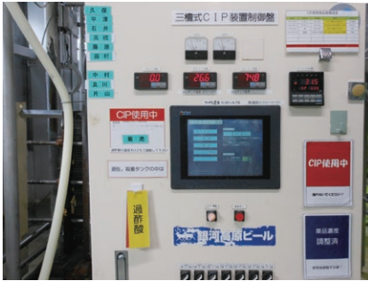
定置洗浄 (CIP 洗浄) の制御盤。何の薬剤を使用しているかなど、必要な情報はすべて「見える化」している
