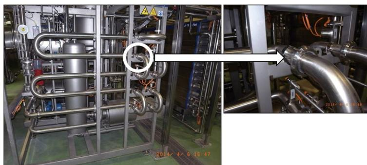
写真5 充てん機のパルプでは、配管内面を2周ふき取る (⇒は製品の流れを示す)
