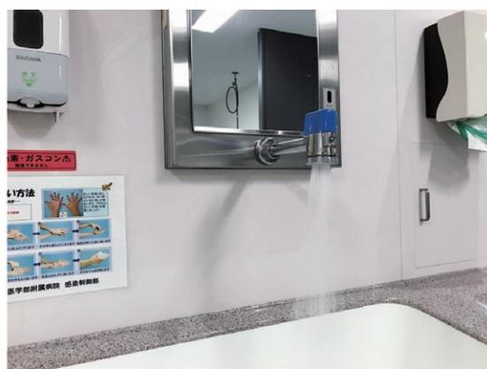
用手洗浄のために 4 台のシンクを設置。手をかざすと水が出る非接触タイプの自動水洗を採用
