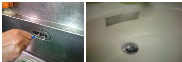
写真 17 シンクのオーバーフローも重要な衛生管理ポイント
