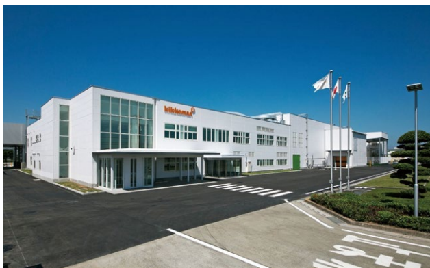
写真1 キッコーマンソイフーズ(株)茨城工場(茨城県猿島郡五霞町、敷地面積:約3万8000㎡、延べ床面積:約1万9000㎡、生産能力:約9万パック/日、従業員数は約60人/2014年3月現在)
