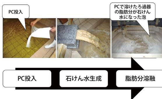
写真6-2 PC工法の手順：②アルカリ洗浄
