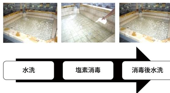
写真6-4 PC工法の手順：④水洗～消毒
